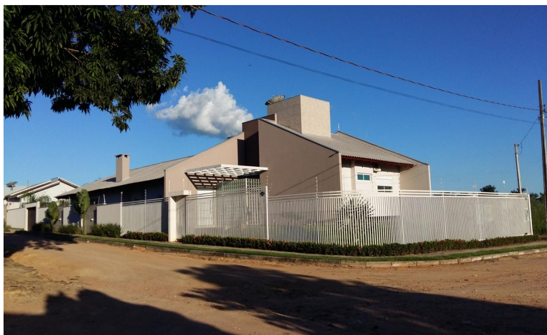
Figura 42. Foto de uma casa que se enquadra na classe em alvenaria tipo A, no Bairro Jardim Vitória.
