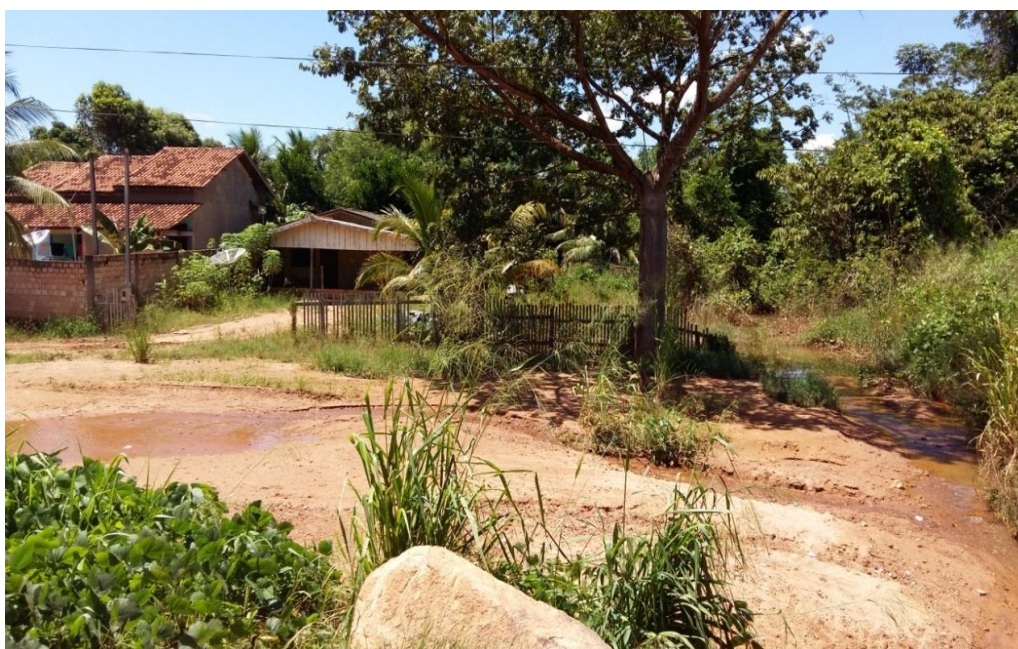
Figura 45. Casa em área de risco de alagamento.
