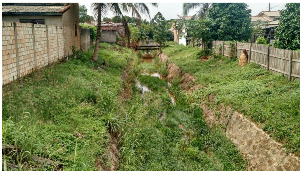
Figura 118. Canalização do córrego Central.
