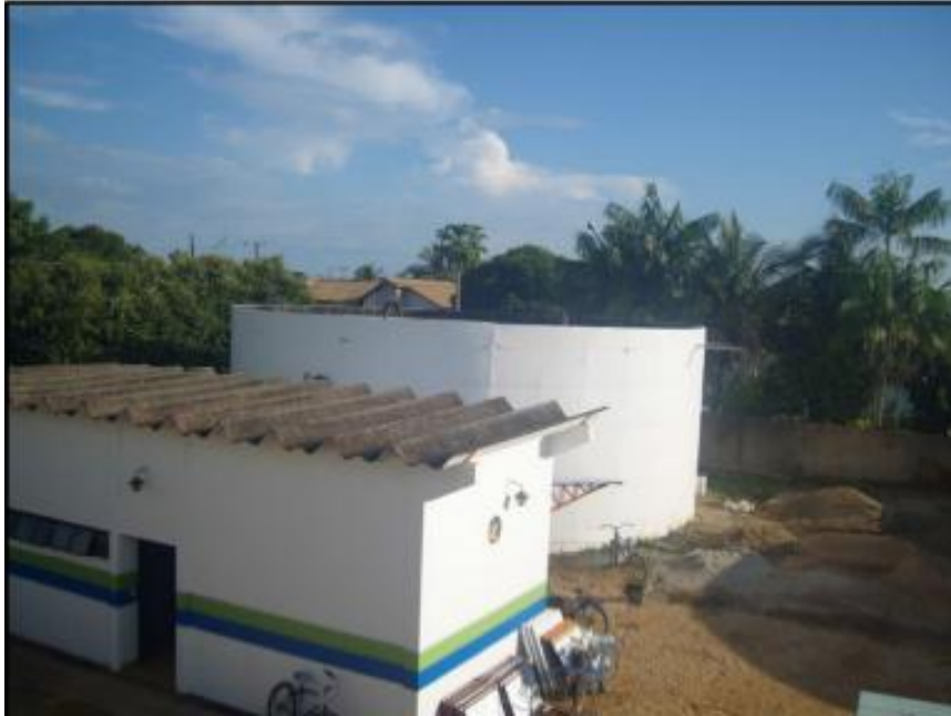
Figura 65. Abrigo da EEAT.
