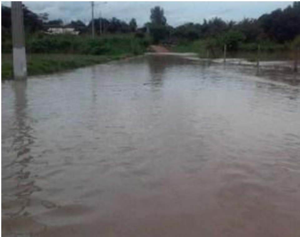
Figura 125. Rua totalmente alagada no Bairro Aeroporto.
