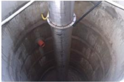
Figura 78. Tamizador e Elevatória de Esgoto.
