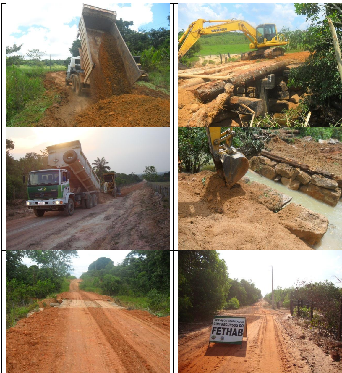
Figura 143. Fotos cedidas pela Secretaria de Infraestrutura, das principais atividades efetuadas nas vias rurais, com foco nas pontes e bueiros. Localidades: Linha 27: Zé da Coca e Coluna de Betel, Linha 52, Linha Boi Nelore, Linha Páscoa 5 e Vale do XV.
