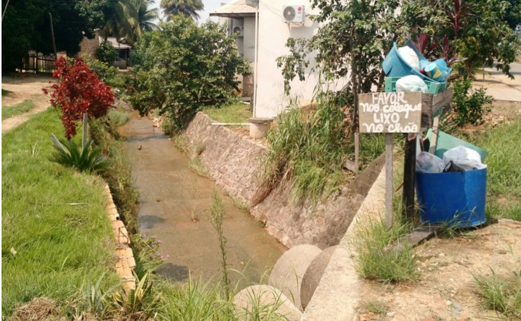
Figura 117. Canalização do córrego Central.
