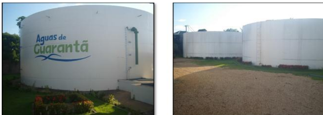
Figura 64. RAP 03, RAP 01 e RAP 02 em concreto armado.
