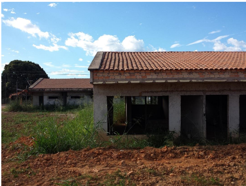
Foto 06 – Vista da parte externa (fundos)
