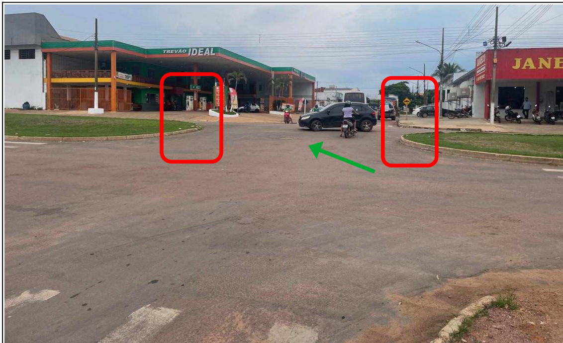
Foto 1: Lacunas de Implementação de Sinalização Vertical R1. 30/10/2025. Canteiro central da Av. Senador Jonas Pinheiro (Maricá) com R. das Castanheiras. Ausência de pinturas da sinalização horizontal (seta verde).
