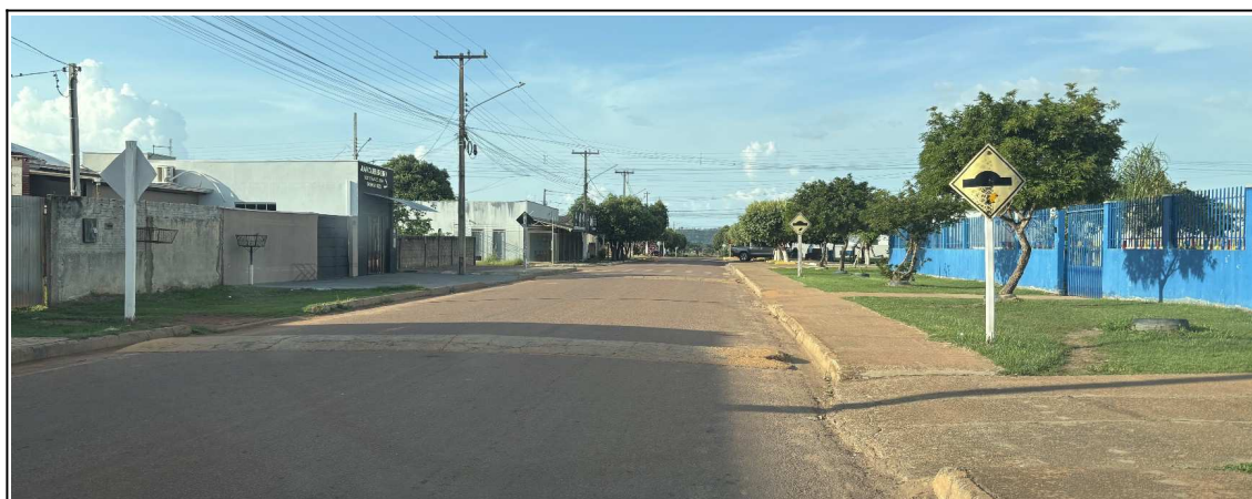
Foto 64: 09/11/2025. Presença de duas ondulações transversais (lombadas) seguidas (distância muito curta uma da outra). Avenida Cuiabá (Ref.: CMEI Gabriela Torezan).
