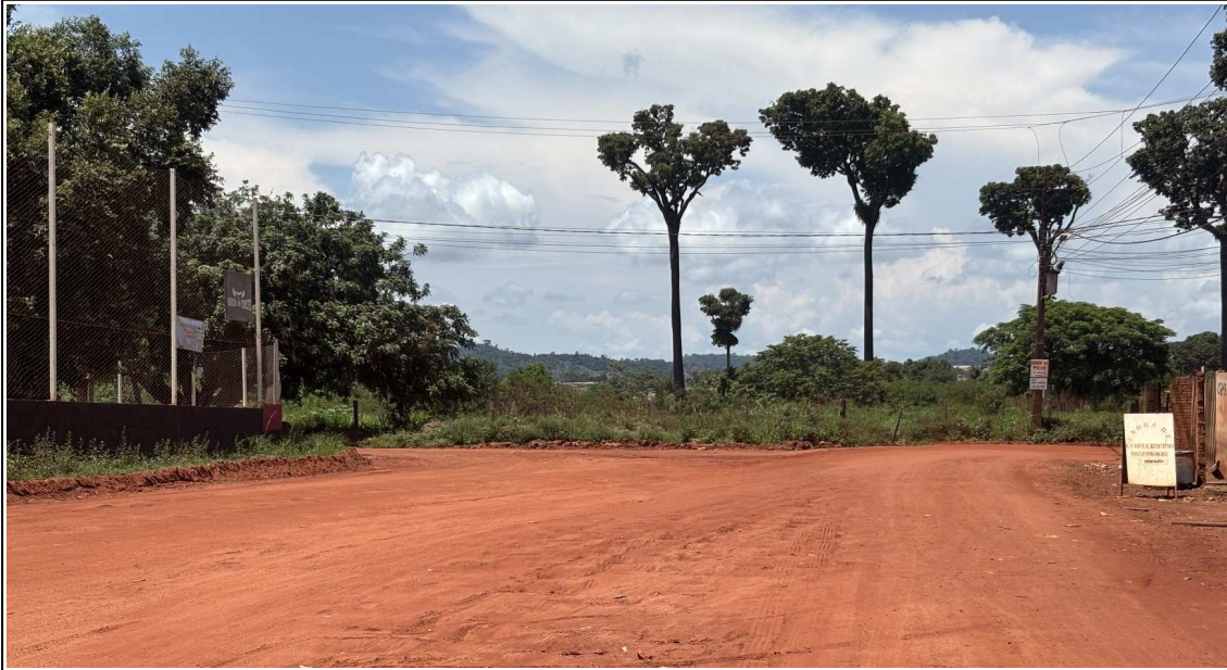
Fotos 11: Lacunas de Implementação de Sinalização Vertical, em estradas de terra batida. 09/11/2025. Interseção R. dos Gaviões, com R. Santo Antônio, sentido ao Bairro Santa Marta (Ref.: Clube Chão Batido).
