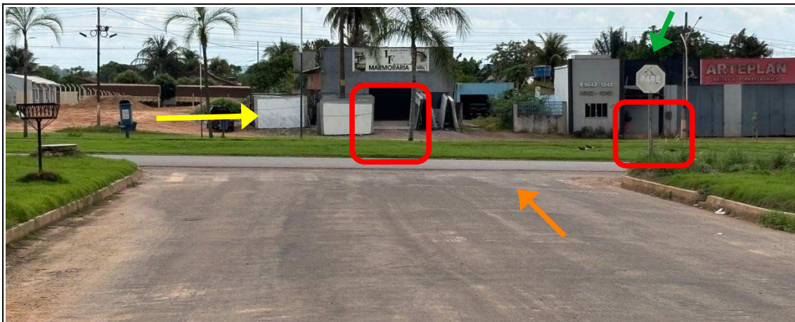
Foto 17: 06/11/2025, bifurcação em T da Av. das Magnólias com Rod. MT 419 (Av. Guarantã), centro. Observar ausência de placa de movimento obrigatório ou proibido. Seta amarela aponta o sentido de fluxo de veículos na Av. Guarantã. Observar também que a sinalização R1 está em condições degradantes (Seta cor verde), assim como a Faixa de Travessia de Pedestre FTP está em fase de manutenção (Seta cor laranja). A qualidade de material usado na FTP era baixa e por isso degradação acelerada.
