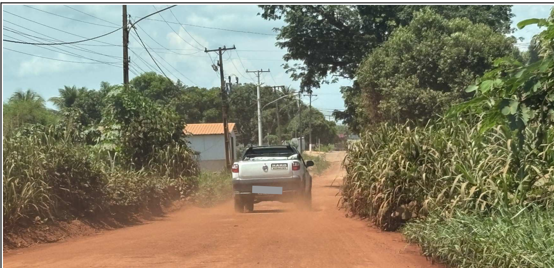
Foto 28: 09/11/2025. R. dos Gaviões, sentido Bairro Santa Marta. Ponte estreita em via de estrada, ausente de sinalização A-22. Observar que somente um veículo de quatro ou mais rodas pode passar de cada vez.
