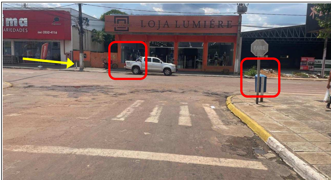
Foto 55: 31/10/2025. Bifurcação em T da R. das Figueiras com Av. dos Jatobás, Centro. Observar ausência de sinal de movimentos proibidos e obrigatórios. Seta amarela aponta o sentido do fluxo de movimento dos veículos da Av. Jatobá (mão simples).
