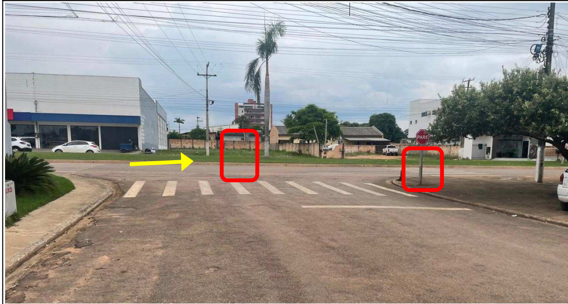
Foto 16: Lacunas de Implementação de Sinalização Vertical – movimentos proibidos e obrigatórios. 30/10/2025. Bifurcação em T da Av. Senador Jonas Pinheiro (Maricá) com R. das Palmeiras (Próximo ao Colégio Inovação). A seta amarela indica o sentido de fluxo obrigatório que os veículos devem tomar.
