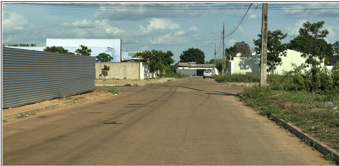
Foto 62: 09/11/2025. Ausência de sinal horizontal e vertical. B. sete de setembro.
