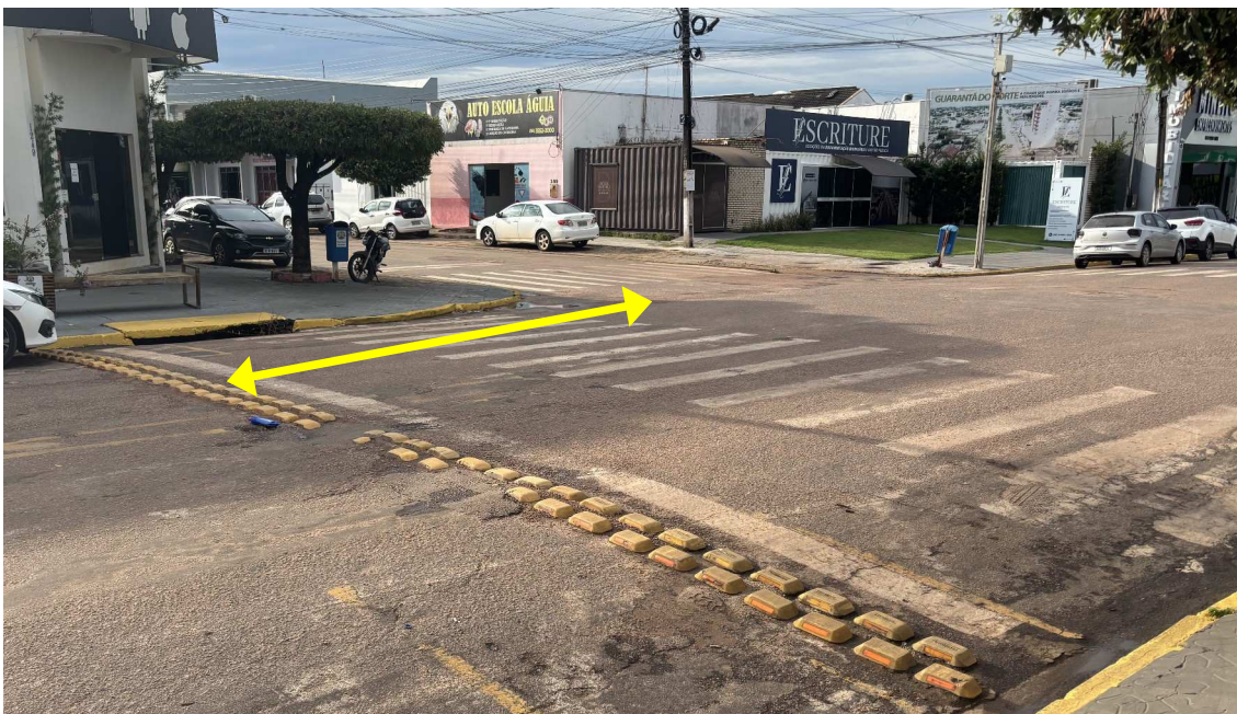
Foto 43: 13/11/2025. Av. Jatobá, nas proximidades de Av. Pioneiro Genésio Minetto (Ref.: Hotel Esplanada). Observar uso errado de duas fileiras de tachões, servindo como lombadas. A distância das tachas até a esquina era curta, de apenas 11,5 metros (seta dupla).
