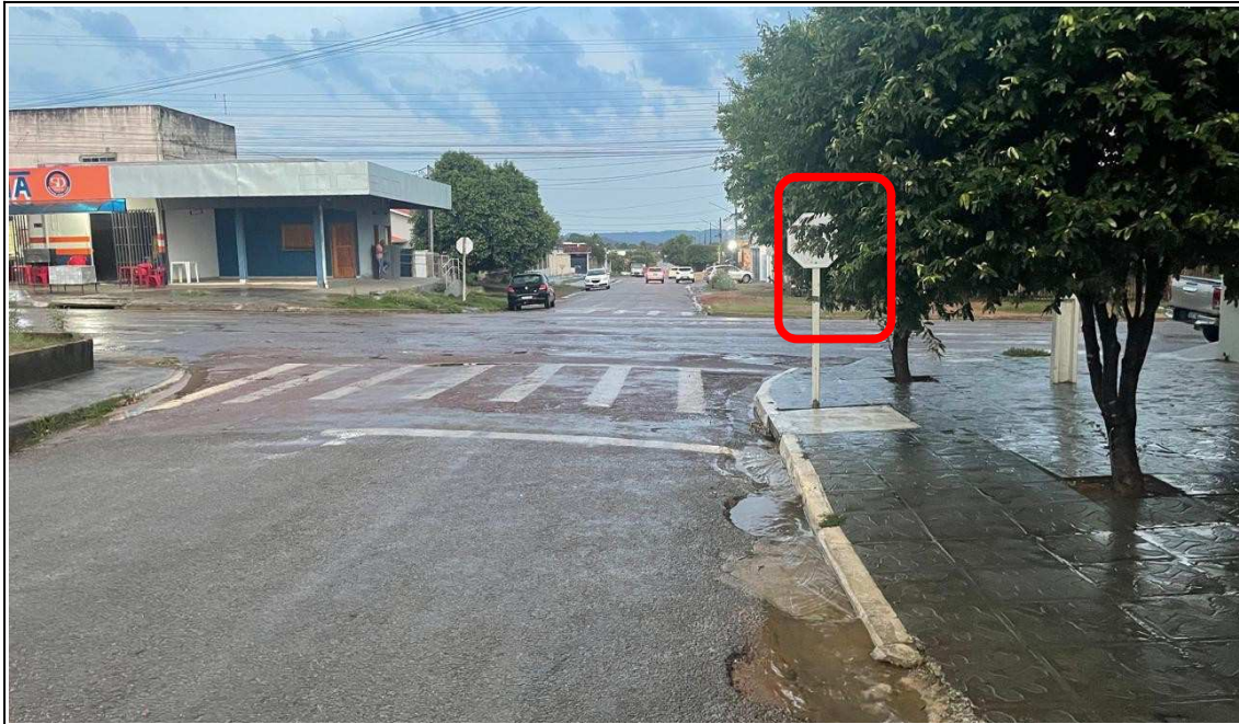
Foto 57: Obstrução da visibilidade pela vegetação. 29/10/2025. Interseção da Av. Magnólias com R. Cedros.
