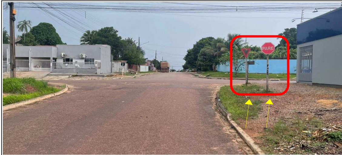
Foto 6: Sobreposição de placas de regulamentação vertical – preferência de passagem (R1 e R2). 30/10/2025. Interseção R. Canjaranas com R. Cedros
