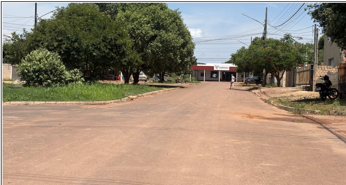
Foto 59: 09/11/2025. Ausência de sinal horizontal e vertical. Av. Nossa Senhora Aparecida B. Santa Marta.
