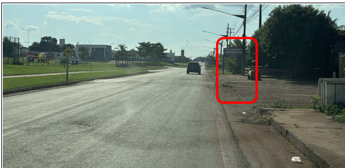
Foto 27. 09/11/2025. Rod. MT 419 (Av. Guarantã) Ref.: Praça do Ciclista. Observar ausência do sinal A-18 na margem da direita da pista. Observar que a ondulação transversal esta praticamente sem pintura.
