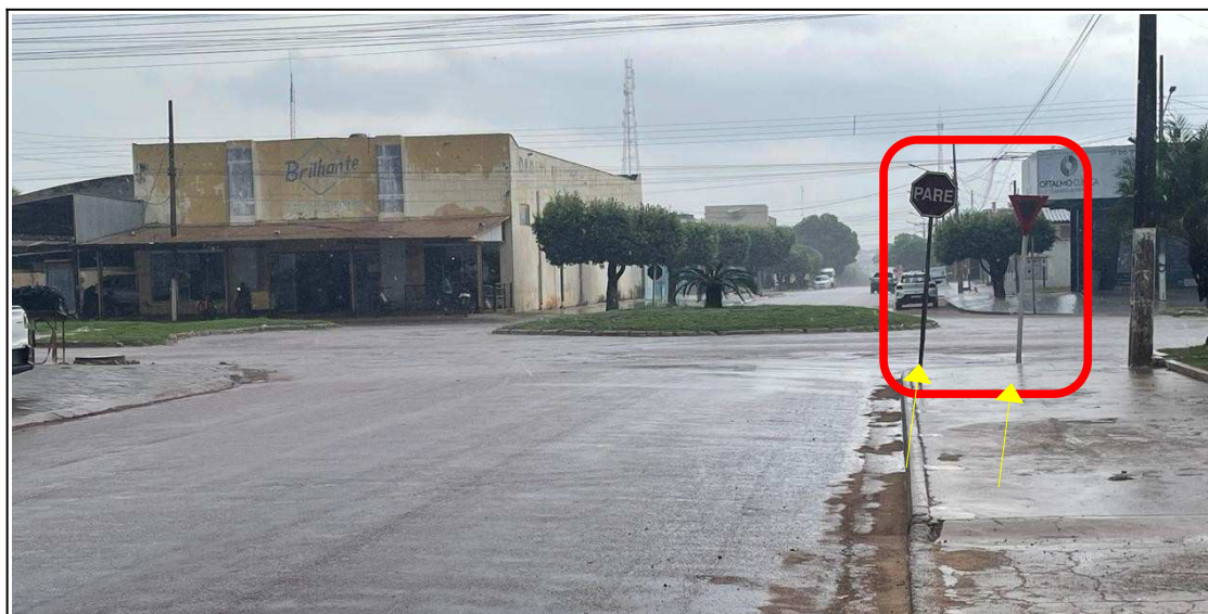
Foto 7: Sobreposição de placas de regulamentação vertical – preferência de passagem (R1 e R2). 30/10/2025. Interseção R. Canjaranas com R. Cedros (Próximo ao Hospital Nossa Senhora do Rosário).
